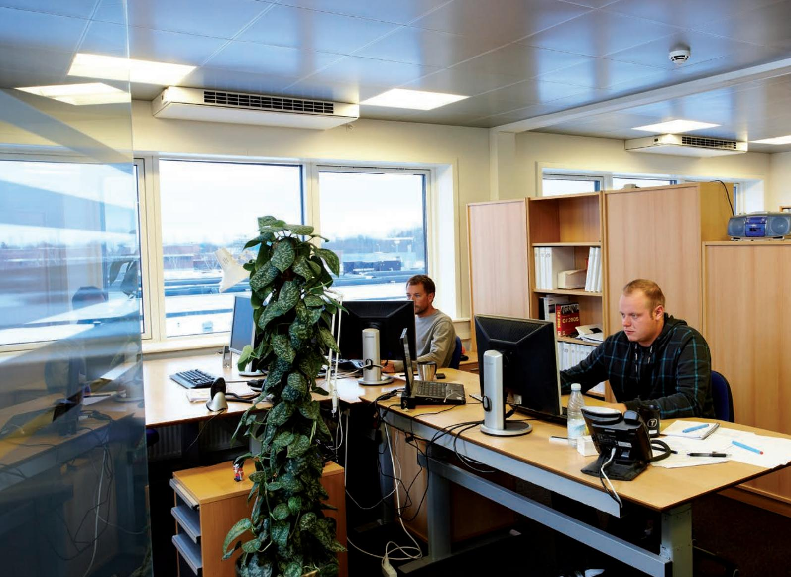
Im Büroraum wurden zwei AM 300-Lüftungsgeräte installiert, wobei 2/3 der Anlage in die Decke integriert wurden.
